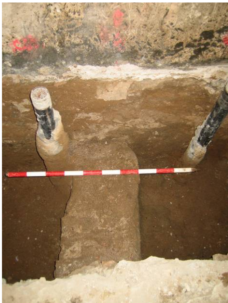
FOTO 11. Riostra (UE 20) de l'edifici actual
