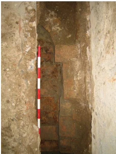
FOTO 7. Rasa 2. Localització de la claveguera UE 13
