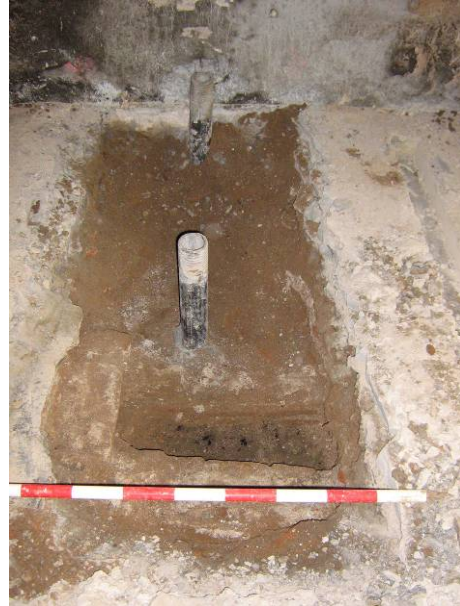
FOTO 6. Foto 6. Vista de la claveguera UE 14 i 24 (rasa 12)
