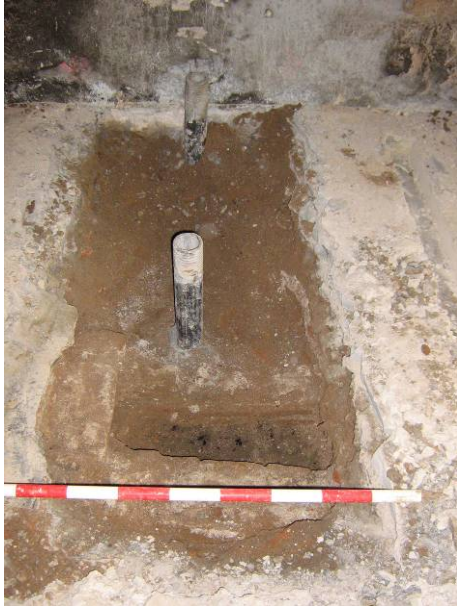
FOTO 9. Rasa 5. Vista de la claveguera UE 15
